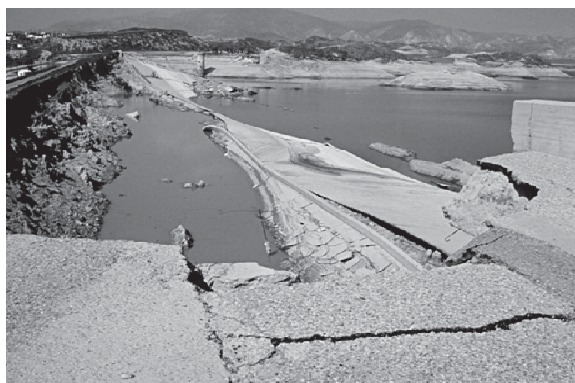
Figura 4. Alunecarea taluzului amonte al barajului Lower San Fernando în urma cutremurului San Fernando, SUA, 1971 (fotografie California Department of Water Resources).
