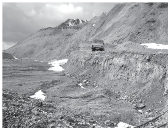
Figura 3. Trepte de alunecare pe halda Cuibarului cu nivelări de ordinul a 2-4 m
