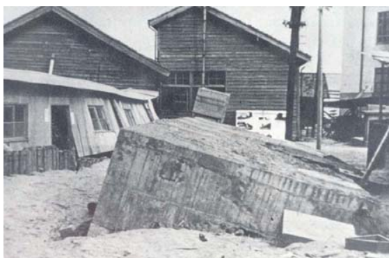
Figura 2. Rezervor inițial îngropat în teren lichefiabil, adus în situația de plutire de cutremurul Niigata, Japonia, 1964 (fotografie de Kawasumi).
