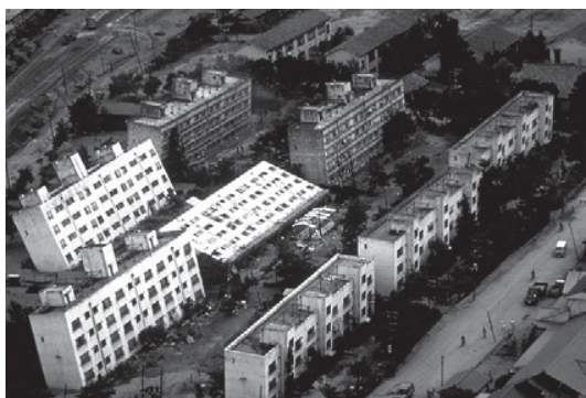
Figura 1. Înclinarea unor blocuri de locuințe indusă de cutremurul Niigata, Japonia, 1964 (fotografie NISEE, EERC, University of California, Berkeley).
