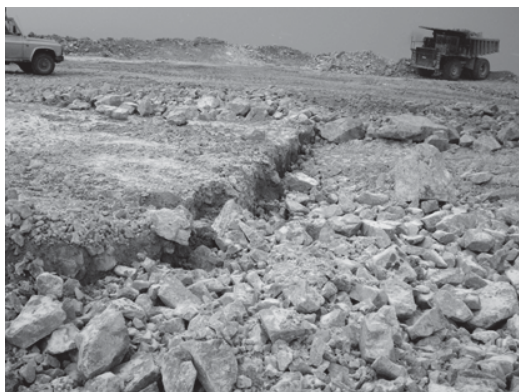
Figura 2. Crăpături pe platforma de depunere a sterilului la partea superioară a haldei Gemenea, în faza de inițiere a alunecării
