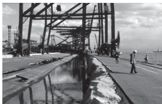
Figura 5. Deplasarea unui zid de cheu, formarea unei ridicături în spatele lui și distrugerea unor macarale la Port Island, după cutremurul Kobe, 1995.
