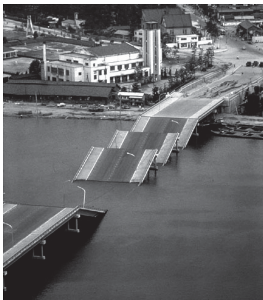
Figura 3. Distrugerea podului Showa în urma lichefierii și a deplasărilor laterale produse de cutremurul Niigata, Japonia, 1964 (fotografie NISEE, EERC, University of California, Berkeley).
