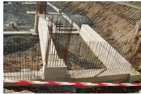
Figura 12. Grinzi de echilibrare fundații excentrice
