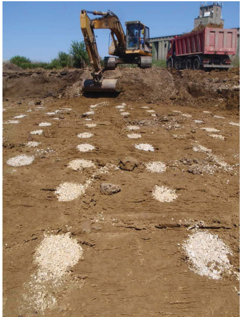
Coloane din material granular executate de KELLER Geotechnica in amplasamentul „Fabrica Bio-Diesel“, Lehliu-Gara, Calarasi
