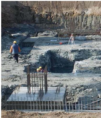
Figura 11. Cuzinet de beton armat
