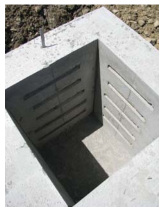
Figura 1b: Talpă monolită+guler prefabricat Lucrări reprezentative: Cora Cluj Napoca, Dedeman(Reșița, Cluj-Napoca, Alba Iulia), Ina Shaeffler Brașov, Kaufland(Mieciurea Ciuc, Carei, Oradea), Mall Ploiești.
