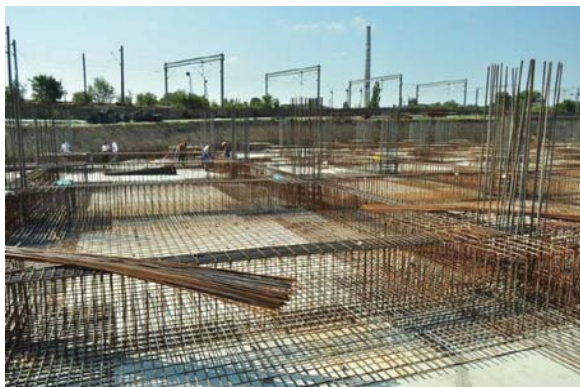
Figura 5: Armarea radierului și a grinzilor Lucrări reprezentative: Centrul Comercial CORALL Constanța
