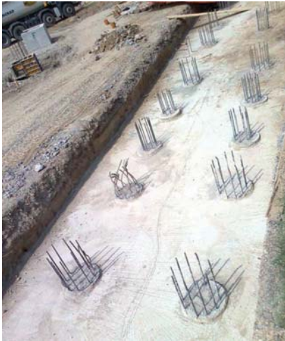
Figura 7: Realizarea fundațiilor pe piloți
