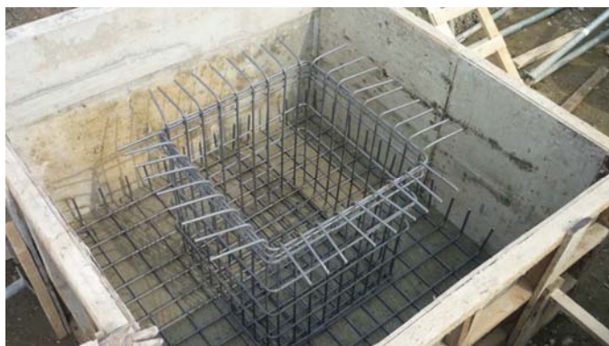
Figura 2b: Fundații pahar tip bloc
