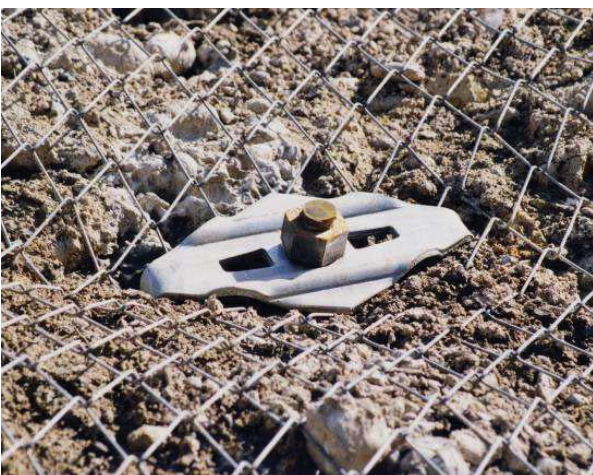
Figura 1. Stabilizare activă a taluzurilor din sol sau rocă cu plase din oțel de înaltă rezistență în combinație cu ancorajul pentru sol sau rocă
