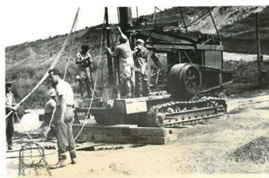
Figura 7. Aspect din timpul execuției (1958).
