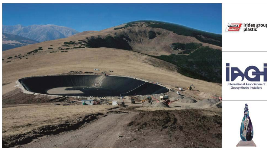
Figura 1. Imagine a lacului artificial Mioarele etanșat cu geomembrană
