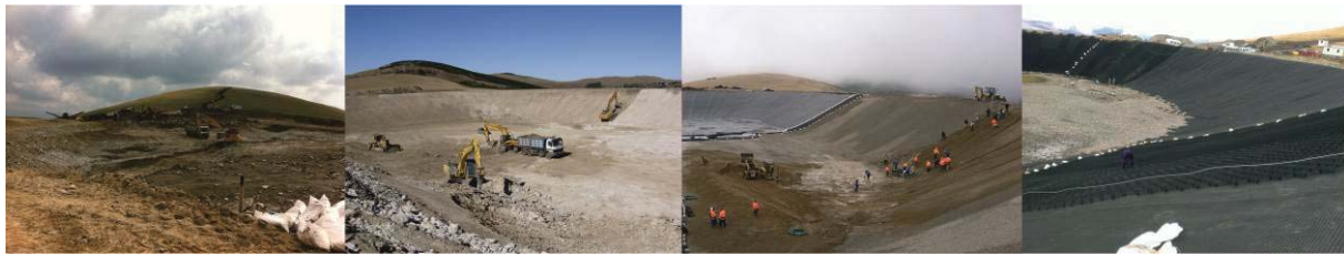
Figura 3. Aspecte din timpul execuției
