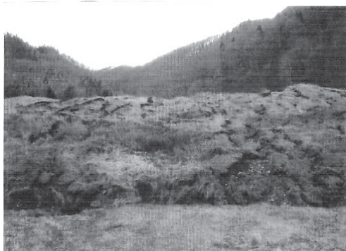
Figura 3. Baza unei alunecări de teren la limita inferioară a benzii de acoperire (vezi punctul 5 din figura 4)
