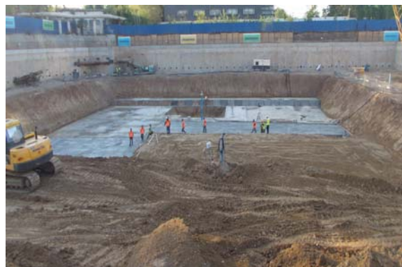
Figura 2. Imagine din timpul execuției excavației
