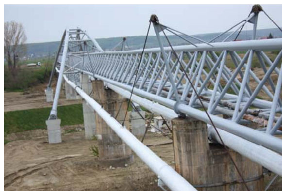
Figura 16. Vechea și noua structura metalică
