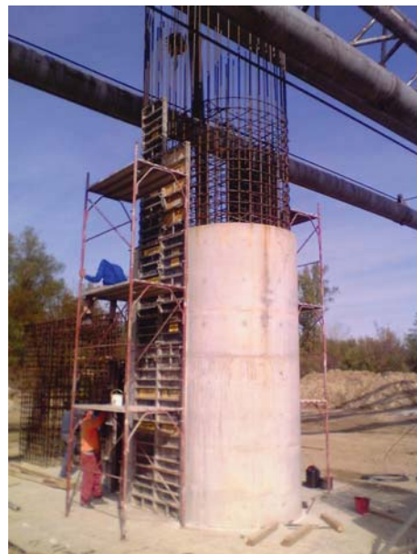
Figura 15. Stâlp central în timpul execuției
