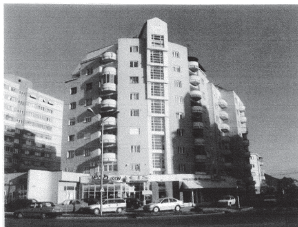
Figura 9 Blocul 2A din P-ța Spitalului Arad fundat pe teren îmbunătățit prin vibroînțepare
