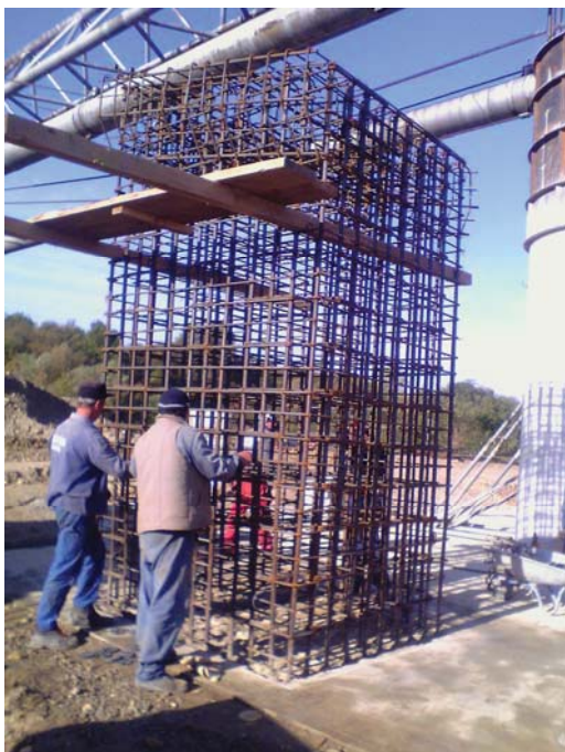
Figura 14. Carcasa de armătură a unui stâlp de susținere
