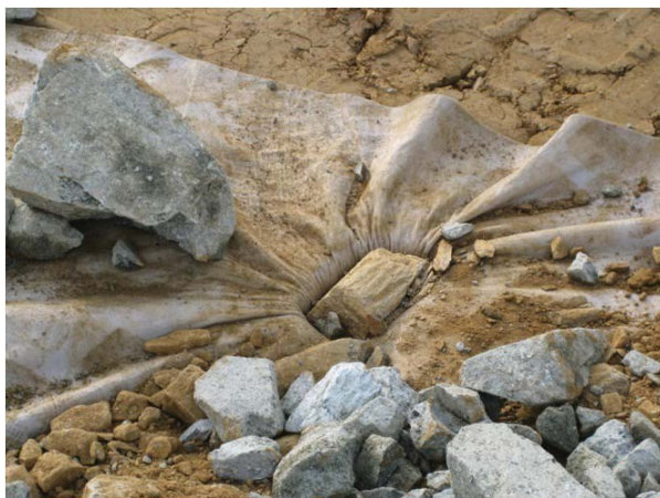
Figura 4. Geotextil așezat pe un pământ slab - TenCate Polyfelt TS.
