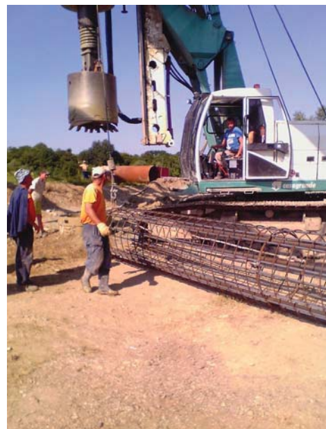
Figura 11. Instalație de forat tip Casagrande B 250 XP
