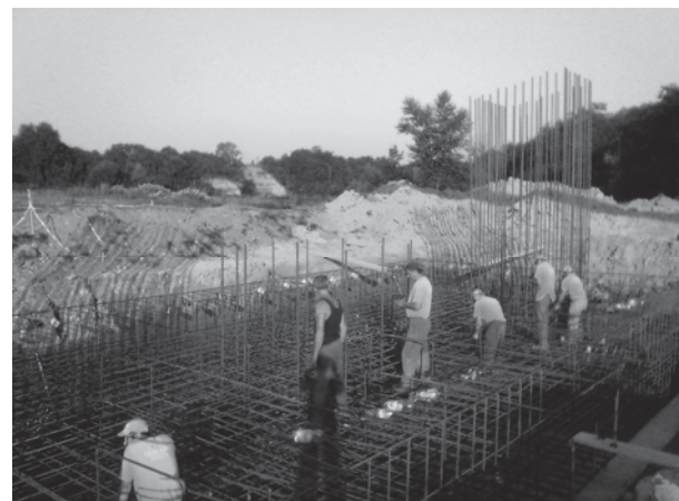
Figura 12. Carcasa de armătură a radierului general
