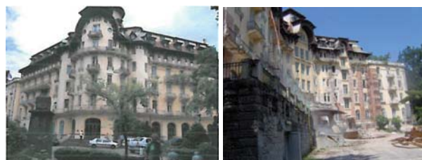
Figura 1. Hotel “Palace”(fațadă principală și fațadă secundară)
