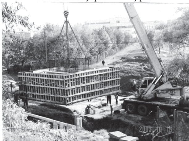
Figura 10 Execuția fundațiilor stâlpilor instalației de nocturnă la stadionul Dan Păltinișan din Timișoara.
