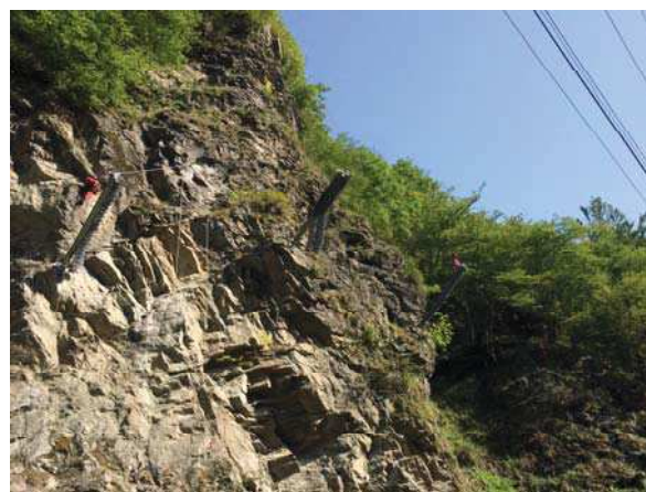
Foto 2 – Instalarea cablurilor superioare
