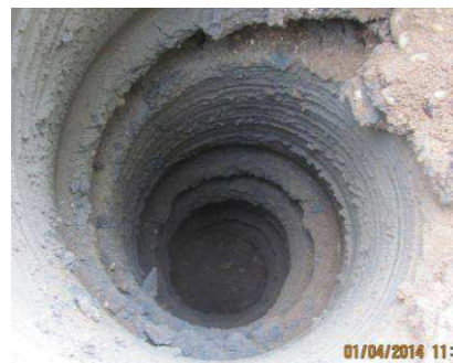
Figura 9. Foraj de probă a unui pilot Screwsol®
