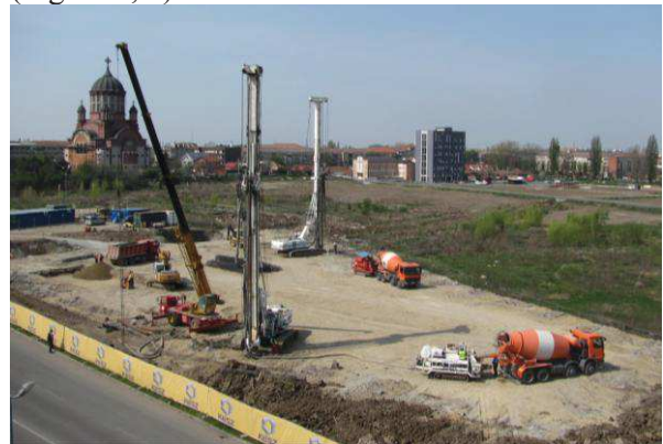
Figura 4. Vedere de ansamblu a șantierului
