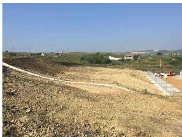
Figura 2. Vedere de ansamblu a sistemului de consolidare
