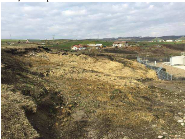
Figura 1. Vedere de ansamblu a alunecării de teren Sistemul de consolidare a alunecării de teren este din piloți forajați de beton armat, cu diametrul de 600mm, având o lungime de 10,50m, dispuși în grupuri de 4 piloți legați la partea superioară cu un radier de beton armat de grosime 80 cm. Distanța inter ax dintre grupurile de piloți legați cu radier la partea superioară este de: 6,00 m. Lungimea
