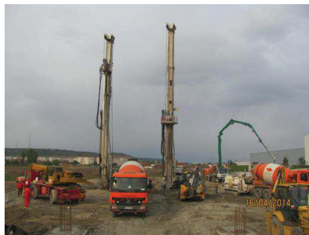
Figura 5. Poză din timpul execuției
