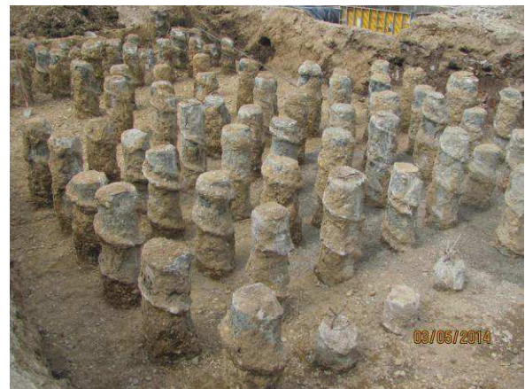
Figura 8. Piloții Screwsol® dezveliți
