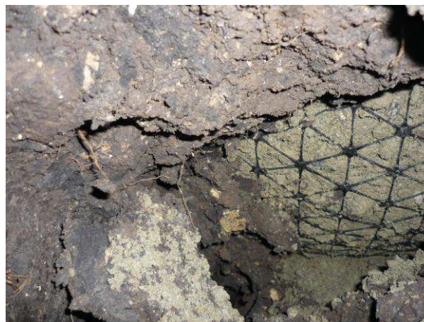
Figura 5. Prăbușirea pământului permite vizualizarea confinării
