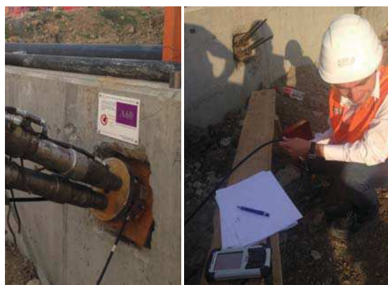
Figura 11. Imagini din șantier Timpuri Noi, Etapa 1A din București, în timpul măsurării forțelor din ancorajele în teren în timpul tensionării și blocării acestora
