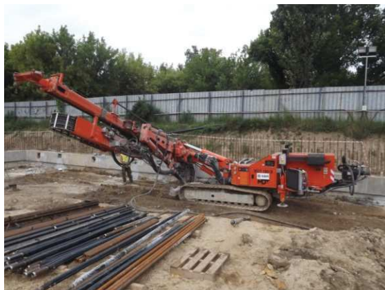
Figura 6. Utilajul folosit pentru forarea și instalarea ancorelor
