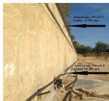
Figura 5. Perete mulat Park Lake Plaza - secțiunea A-A
