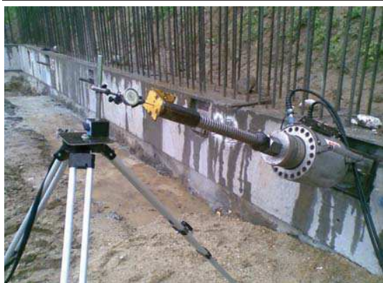
Figura 8. Aranjamentul echipamentelor pentru realizarea încercărilor
