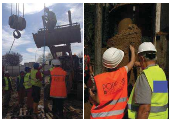
Figura 7. Imagini din șantiere în lucru, oferind asistență tehnică pentru situațiile întâlnite pe amplasamentul în timpul execuției
